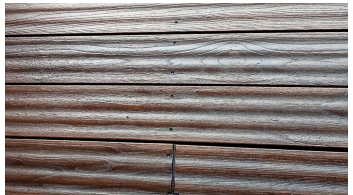
Renovierte Terrasse aus Thermo-Esche nach der Veredelung mit DeckFinish Color Dunkelbraun.
